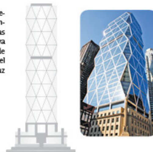
Torre Hearst. Las formas triangulares de esta torre se conocen también como estructura diagonal.
